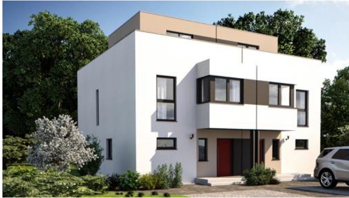
Abbildung 6: Referenzgebäude Neubau, Vorderansicht
