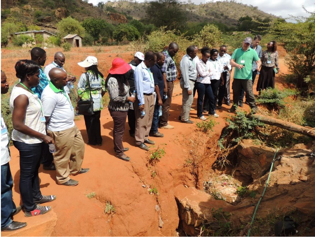
Prof. Jüpner (im grünen Polo-Shirt) erläutert Erosionsschäden an der technischen Infrastruktur in Voi.
