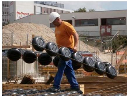
durch deren Kombination sich sieben verschiedene Hohlkörperdimensionen mit einer Abstufung von 20 mm in der Höhe ergeben. Dies ermöglicht eine Anpassung an Deckenstärken von 200 mm bis 350 mm.
