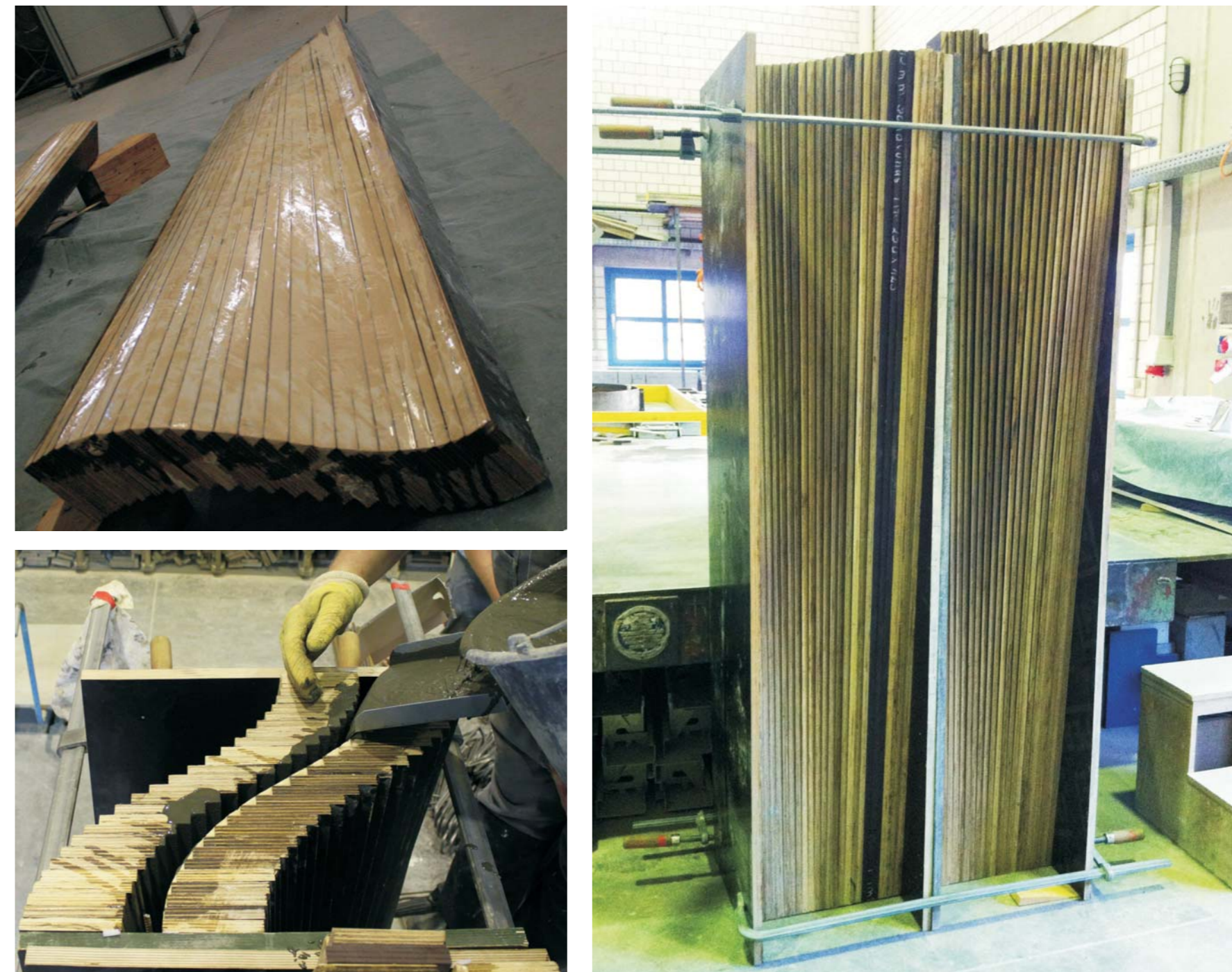
Schalung aus geraden Multiplexstreifen
