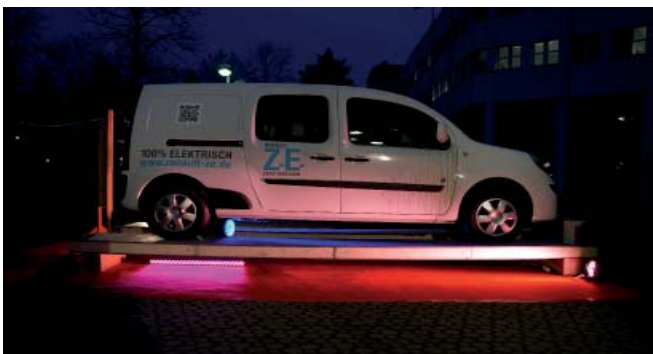
Renault Kangoo Z.E. auf einer Brücke aus Sandwichelementen aus Hochleistungsbeton mit Styrodurkern. Bildquelle: Fachgebiet Massivbau und Baukonstruktion, TU Kaiserslautern.
