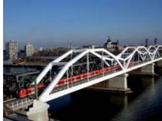
Eisenbahnbrücke zwischen Ludwigshafen und Mannheim Foto: www.bahn.de
