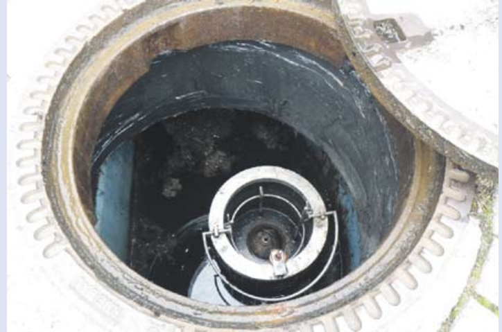
Foto: MC-Bauchemie, Bottrop
